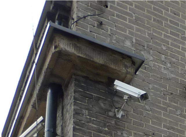
Fot. 20. Uszkodzony gzyms dolny z ciemnymi zaciekami i zabrudzenie muru pod nim, pn.-wsch. narożnik.
