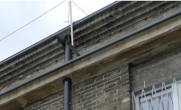
Fot. 14. Zabrudzony schodkowy gzyms, zacieki na gzymsie dolnym i częściowo wyflukany z niego oryginalny tynk.
