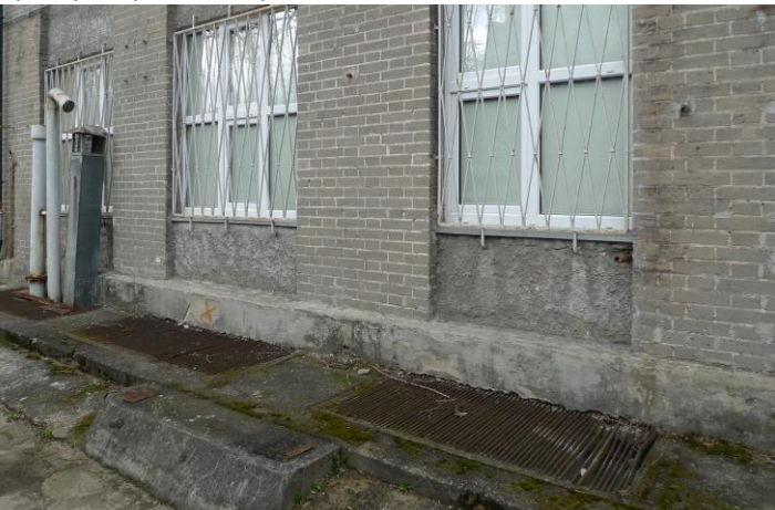
Fot. 16, 17. Betonowa wylewka wokół budynku porośnięta porostami, zawilgocona, z zaciekami po stojącej na niej wodzie oraz popękany (miejscami prowizorycznie uzupełniony) cokół budynku, elew. pd...
