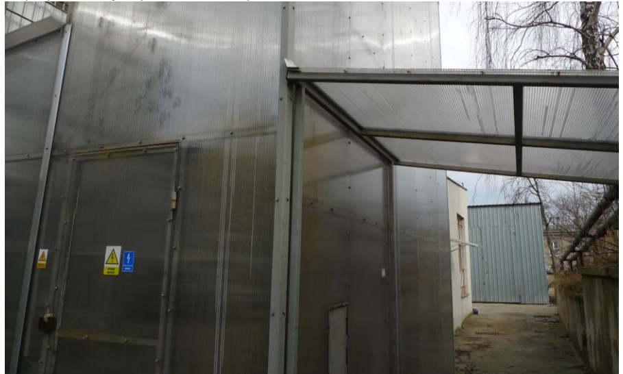
Fot. 23. Nieestetyczna przybudówka z mało trwałego i nieestetycznie starzejącego się materiału - poliwęglanu komórkowego; widoczne zabrudzenia i porosty wewnątrz komórek ścianek, elew. wsch. H/E3.
