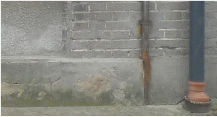
Fot. 10, 11. Zamknięty, popękany i porośnięty glonami cokół – przyczyną może być niespełniająca już swej funkcji izolacja muru fundamentowego, szczelna opaska utrudniająca odparowywanie wody ze ściany poniżej poziomu gruntu, niedrożna instalacja odprowadzania wody opadowej; elew. zach..
