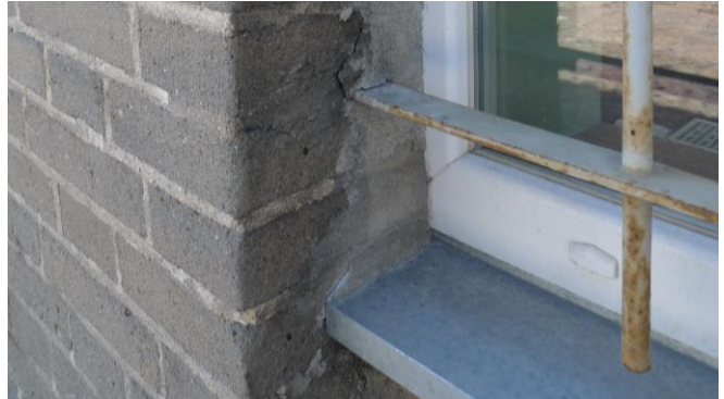
Fot. 32. Prowizoryczne, nieestetyczne kity założone w miejscu niewielkich ubytków (najprawdopodobniej po pociskach) w cegle i fudze, elew. pd..
