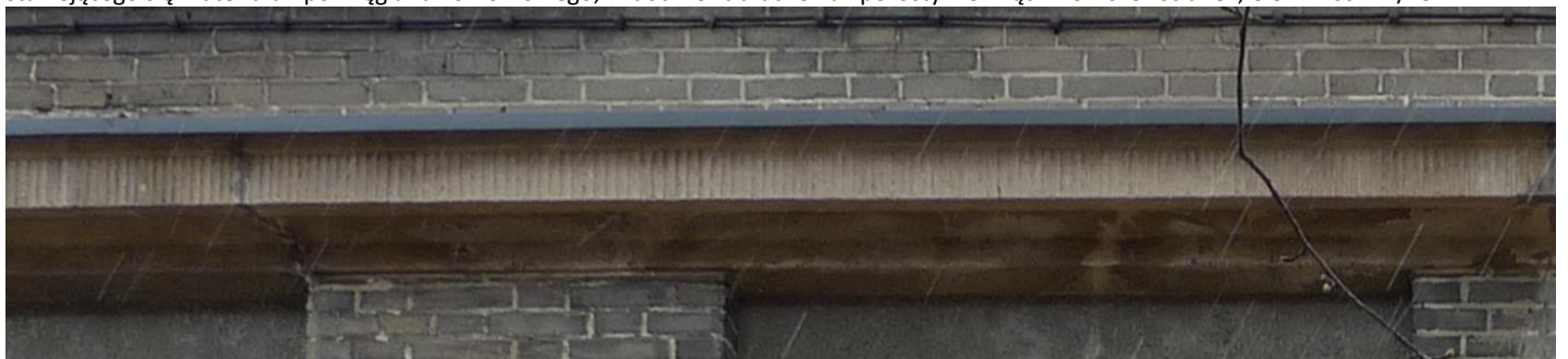
Fot. 24. Pęknięcie w dolnym gzymsie oraz zacieki na jego powierzchni, elew. pn. H/E2.
