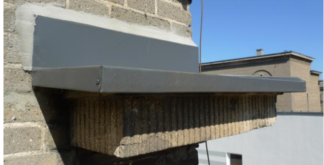
Fot. 28. Wtórne okna z PCV nawiązujące do oryginalnych, elew. zach. H/E1. Fot. 29. Opierzenie blacharskie w bardzo dobrym stanie, elew. H/E3
