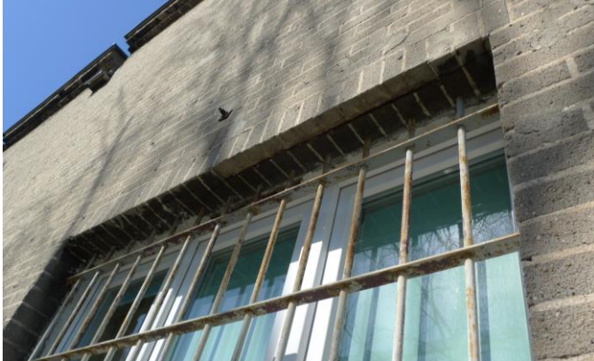
Fot. 30. Korozja stalowych nadproży okiennych w elew. H/E3. Fot. 31. Pokrycie dachu przybudówki elewacji wsch. - w bardzo dobrym stanie.
