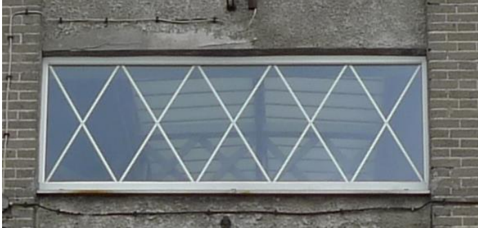
Fot. 28. Wtórne okna z PCV nawiązujące do oryginalnych, elew. zach. H/E1. Fot. 29. Opierzenie blacharskie w bardzo dobrym stanie, elew. H/E3
