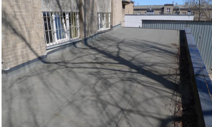
Fot. 30. Korozja stalowych nadproży okiennych w elew. H/E3. Fot. 31. Pokrycie dachu przybudówki elewacji wsch. - w bardzo dobrym stanie.
