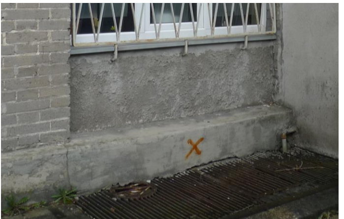
Fot. 14. Zabrudzony schodkowy gzyms, zacieki na gzymsie dolnym i częściowo wyflukany z niego oryginalny tynk.
