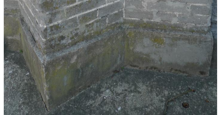
Fot. 12. Wyflukana częściowo opaska betonowa wokół budynku, porośnięty glonami cokół, pn.-zach. narożnik budynku.
