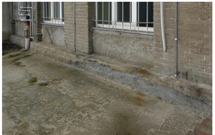
Fot. 16, 17. Betonowa wylewka wokół budynku porośnięta porostami, zawilgocona, z zaciekami po stojącej na niej wodzie oraz popękany (miejscami prowizorycznie uzupełniony) cokół budynku, elew. pd...
