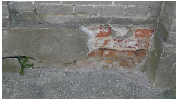
Fot. 10, 11. Zamknięty, popękany i porośnięty glonami cokół – przyczyną może być niespełniająca już swej funkcji izolacja muru fundamentowego, szczelna opaska utrudniająca odparowywanie wody ze ściany poniżej poziomu gruntu, niedrożna instalacja odprowadzania wody opadowej; elew. zach..
